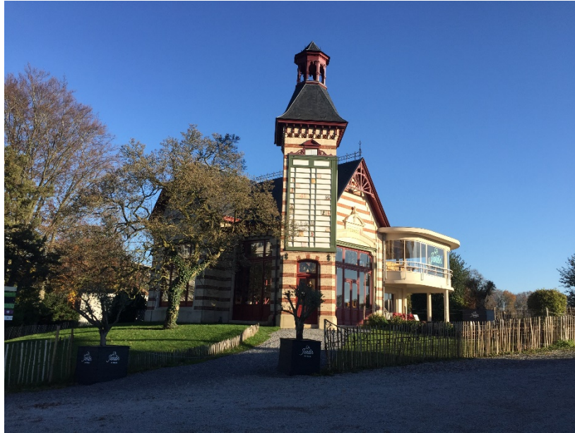
Photo 3 : Bâtiment du Pesage
